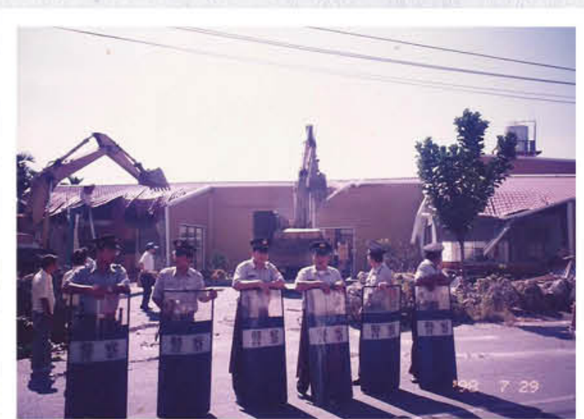
◀拆除現場派警維持秩序
